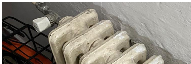
Obrázek 5. Otopná tělesa ve společných prostorech neosazena termostatickými hlavicemi.
