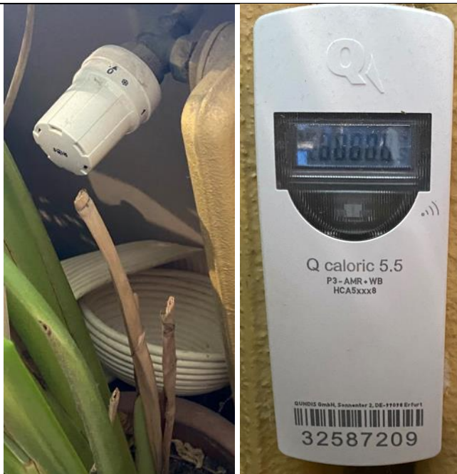
Obrázek 4. Otopná tělesa jsou osazena termostatickými hlavicemi a mají poměrová měřidla spotřeby s dálkovým odečtem..
